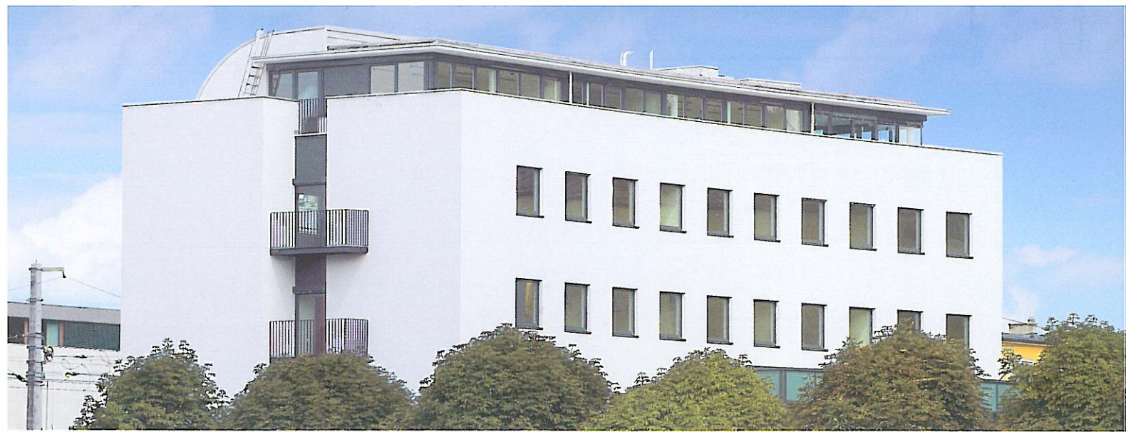
ANSICHT VOM SALZACHKAI mit den Schallschutzfenstern der Musikräume und dem Terrassengeschoss.
