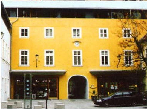
ALTHAUSSANIERUNG MÖBELHAUS JAKOLITSCH
