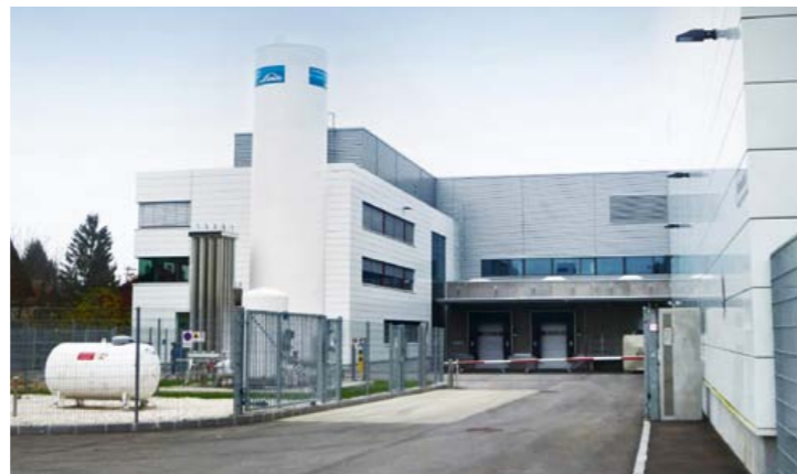
EPL. Neubau Betriebsgebäude, Unterach am Attersee
