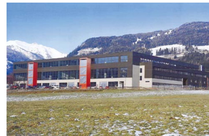
MAYR & CO. Neubau Produktionshalle, Mauterndorf
