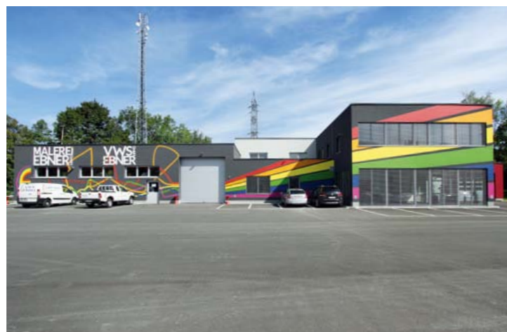
MALEREI EBNER. Neubau Betriebsgebäude, Hallein
