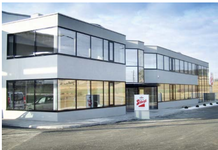
STIEGL BRAUEREI. Neubau Vertriebsniederlassung, Loosdorf
