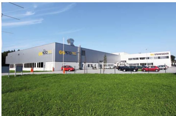
GS STEMESEDER. Betriebsgebäude, Koppl
