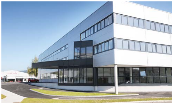
HANNAK/TROST. Neubau Halle, Salzburg
